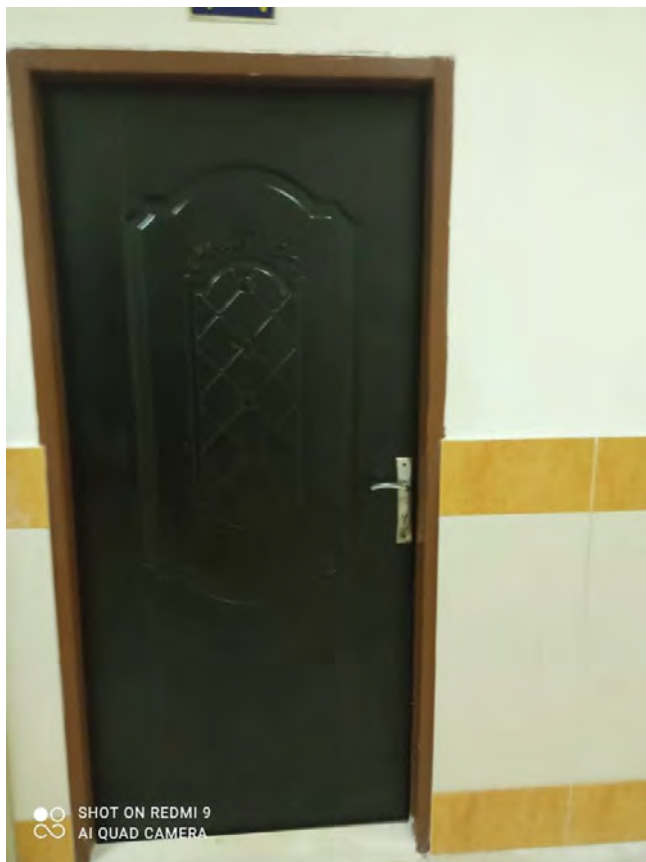
تعویض درب های خوابگاه
