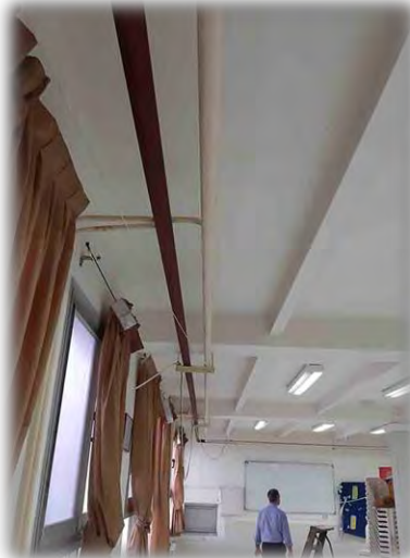
مین اجرا و تعویض لوله تاسیسات آب گرم شوفاژ
