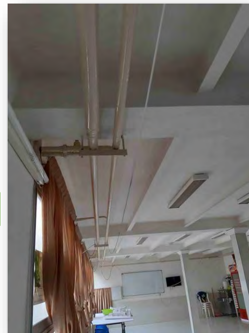
اتمام کار تعویض و رنگ آمیزی لوله های تاسیساتی
