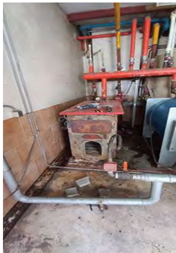
شروع کار و قبل تاسیسات فوابگاه
