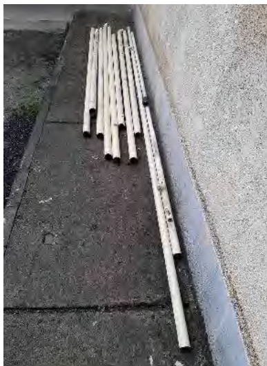
شروع کار و برش لوله های فرسوده تاسیسات فوابگاه
